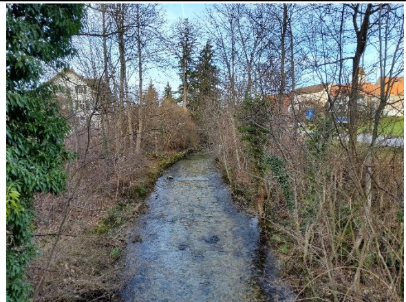
Blick von I14 in Fliessrichtung
