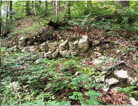
Kleinere potenzielle Ausbruchstellen im Gebiet B
