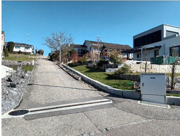
Leimgrubenhübel – Höhenstrasse, Blick nach oben, keine Hinweise auf aktive Rutschung
