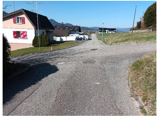
Leimgrubenhübel – Höhenstrasse, Blick nach Westen, keine Hinweise auf aktive Rutschung
