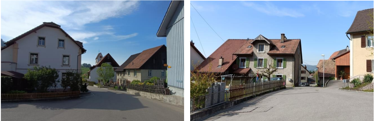
Abbildung 12: Bauerngärten und Baugruppen in der Oberdorfstrasse (links) und der Kirchstrasse (rechts). 7
